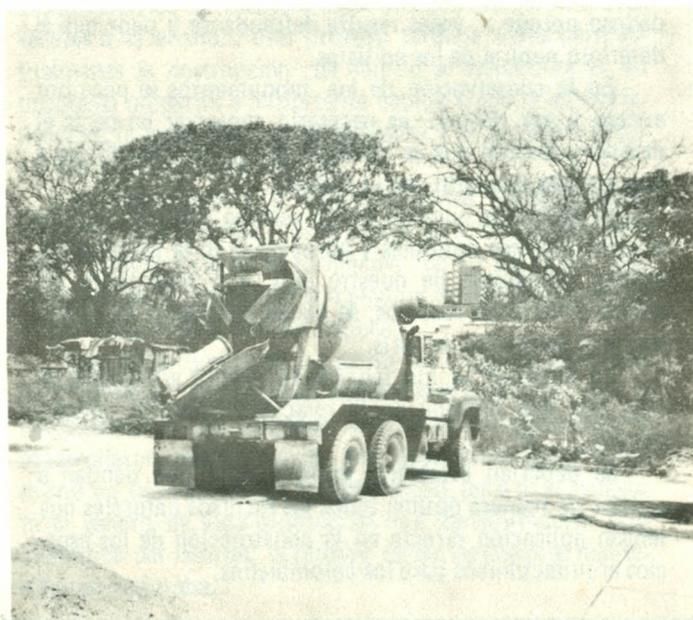
Dicha mezcla fué proyectada para lograr una última resistencia de 3.500 lbs/pulg.<sup>2</sup> 246 Kg/cm.<sup>2</sup> a los 28 días, de modo que sobrepasó ampliamente el valor esperado.
