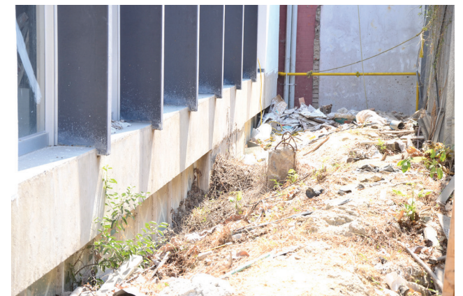
El nuevo edificio multipropósito estará listo al finalizar el segundo semestre de 2015.
