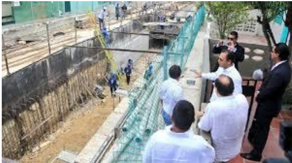
Ilustración 12 Canalizacion de Arroyos
