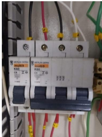
Figura 28. Breaker, Fuente: Imagen de fuente propia.
