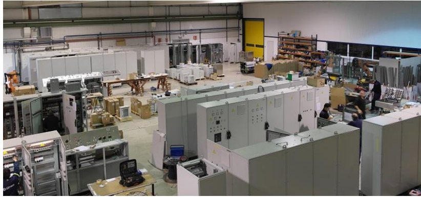
Figura 10. PLC usado en proceso industrial Fuente: versión tomada de fuente online disponible en Aldakin [32].
