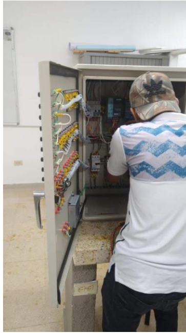
Figura 24. Realizando conexiones, Fuente: Imagen de fuente propia.
