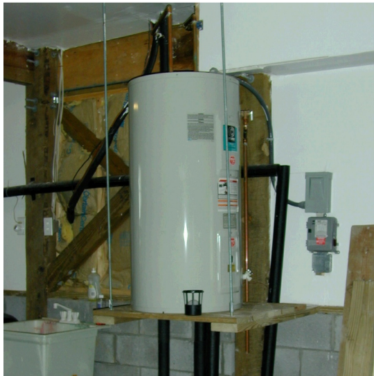
Figura 3. Calentador de almacenamiento tipo tanque.
